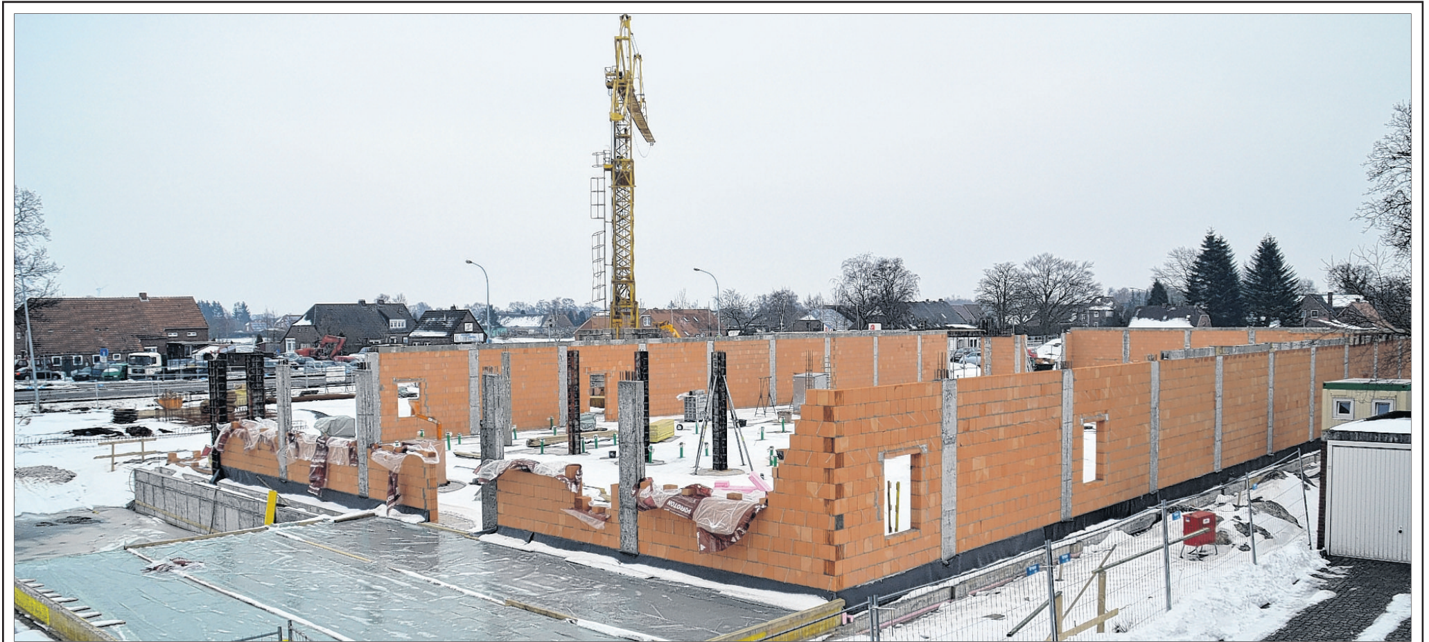
Die Bauarbeiten am Neubau des Neukauf-Marktes in Moordorf sind mittlerweile weiter fortgeschritten. Die ausführende Firma hat die Außenmauern fast fertiggestellt. Der Neubau des 1515 Quadratmeter großen Marktes von Uwe Gerbers soll bis Ostern 2014 fertig werden. Noch im Oktober hatte Inhaber Gerbers seine 50 Mitarbeiter beauftragt, den alten Markt leerzuräumen. Der alte, 947 Quadratmeter große Markt wurde im November abgerissen. Foto: Lindenbeck
