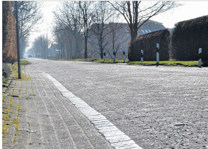
Der Schwarze Weg ist in einem schlechten Zustand.
